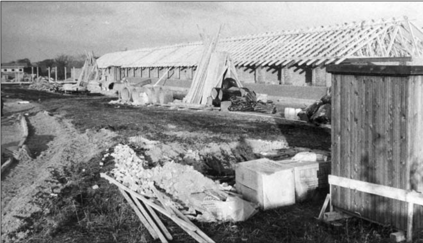
Birkehøj under opførelse i 1969
